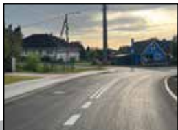
drogi i chodniki
