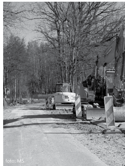
Na ulicy Wiosennej rozpoczęły się pierwsze prace związane z kompleksową przebudową tej drogi.
