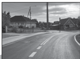
drogi i chodniki
