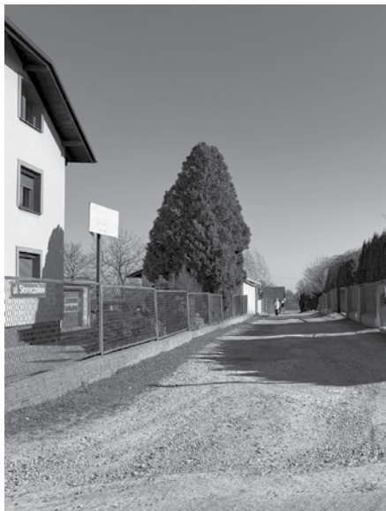
Przebudowa ulicy Słoneczników rozpoczęła się od zrealizowania prac geodezyjnych, niebawem kolejne z nich.
