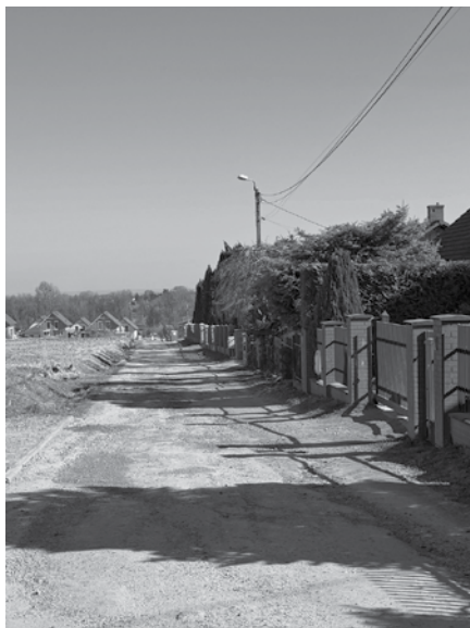
Szutrową nawierzchnię na ulicy Świętego Walentego zastąpi na zakończenie inwestycji asfaltowa.
