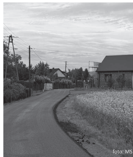
Na wymagającym napraw i remoncie odcinku ulicy Wieżowej została ułożona nowa nawierzchnia na całej szerokości drogi.
