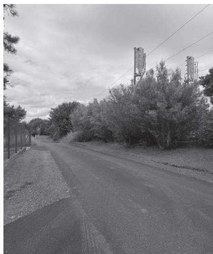
Wysłużona nawierzchnia na ulicy Kolejowej w ostatnich tygodniach zyskała zupełnie nowe oblicze na całej jej długości.
