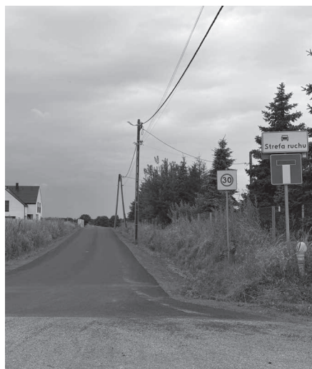
Na odcinku od skrzyżowania z ulicą Przeczną i Jaworową do skrzyżowania z ulicą Malinową, ulica Czapli zyskała zupełnie nową nawierzchnię.
